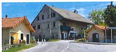
Rénovation des petits hangars 30'000€
