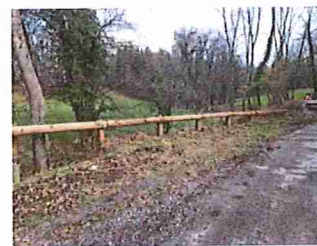
Barrières de protection 7'000€ (Gerbaz et Bontaz)
